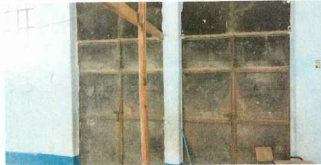
Foto 6: Reparacion de puertas del Centro Educativo.
