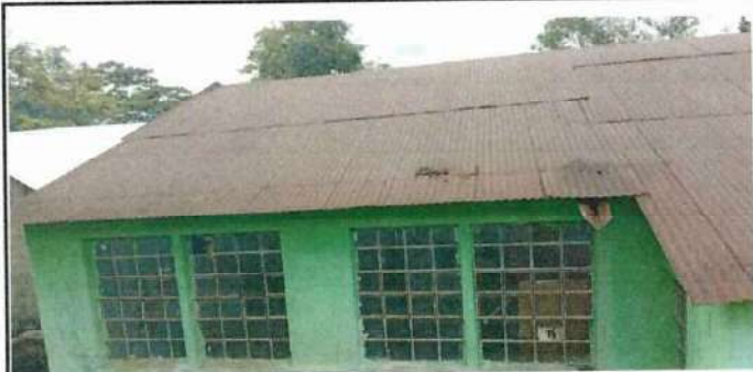
Foto 1: Sustrucion de laminas galvanizadas por laminas troqueldas para todo el Centro Educativo.
