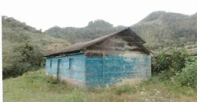
Foto 2: Reparacion y ampliacion de la cocina del Centro Educativo
