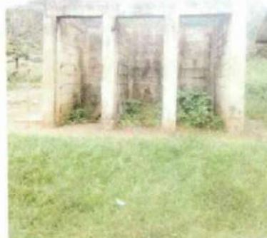
Foto 4: Reparacion y culminacion de baños y sus accesorios
